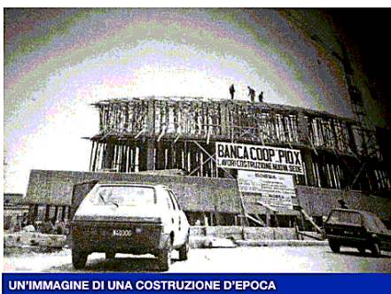
UN'IMMAGINE DI UNA COSTRUZIONE D'EPOCA
